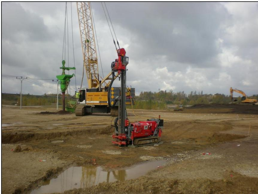
**Abbildung 9: Ménard Pressiometersondierungen zwischen und in den RSV-Säulen**
