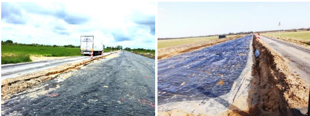
Abb. 9 Vakuum-Fläche zur Vorbelastung der Neutrasse der B202 direkt neben dem Altbestand im einspurigen Betrieb
