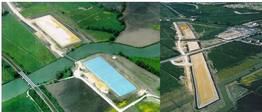
Abb. 13: Luftbildaufnahmen der MVC-Flächen an den späteren Brückenbauwerken der A837
