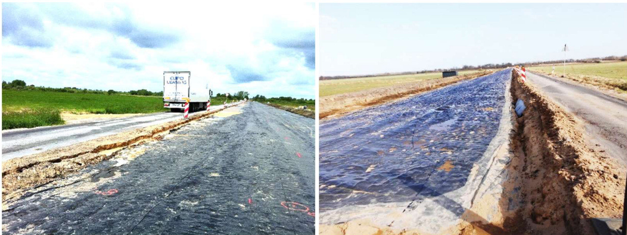
Abb. 5: Vakuum-Block kurz nach Inbetriebnahme (links) und nach ca. 10 Tagen MVC-betrieb bei 60 cm Setzungen (rechts)
