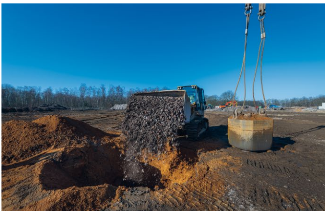
Bild 3 Verfüllung eines Einschlagtrichters in Dorsten mit RC-Baustoffen (links) und fertig hergestellte Säulen (rechts)
