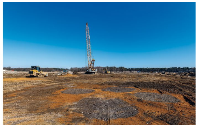
Bild 3 Verfüllung eines Einschlagtrichters in Dorsten mit RC-Baustoffen (links) und fertig hergestellte Säulen (rechts)
